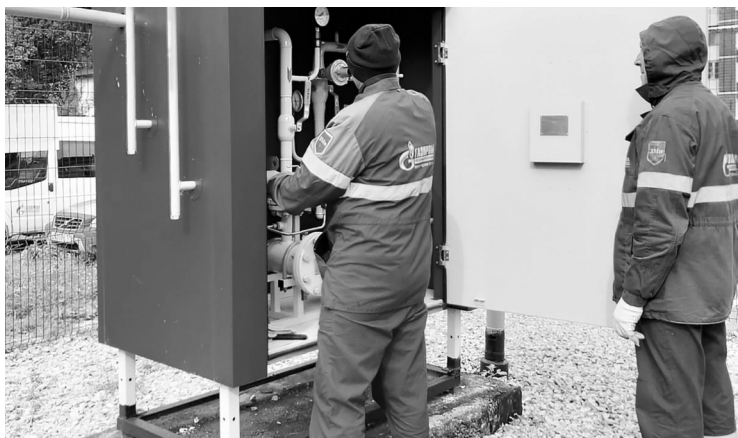
❖ Запуск в эксплуатацию распределительного газопровода в Кикерино
